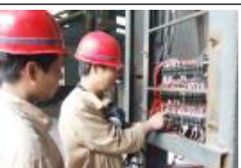
8 月 22 日, 工程公司电装车间成功地对电解厂一车间液压机组 (多功能天车) 进行了解体大修, 及时对电气线路和电气备件进行了彻底更换。邓广顺 杨冬花 摄影/报道
