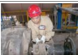
近日, 氧化铝一厂四车间烧成工序托轮岗位 15 名员工, 积极配合工程公司大修 3 号熟料窑。
