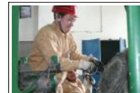
日前, 氧化铝一厂空压站一线员工, 积极维修活塞式压缩机吸、排气阀, 确保了汛期安全生产。图为岗位员工正在检修气阀。
