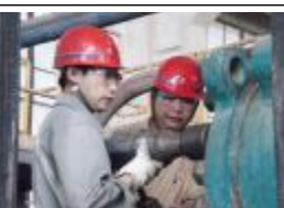
近日, 氧化铝一厂管道车间技术人员同沈阳冶金机械厂共同研讨, 对二管管道系统 3 号隔膜泵进行了改造。
