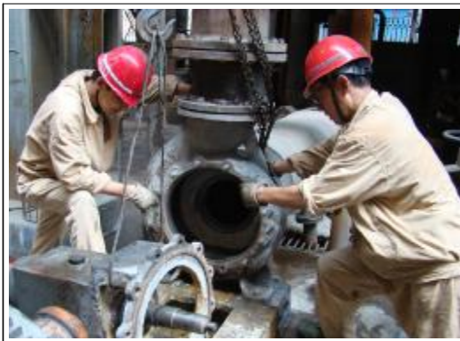
近日, 氧化铝一厂五车间钳工班员工克服气温高、场地狭小、海拔高、噪音大等多种困难, 连续奋战 8 个小时圆满完成七蒸发 5 号循环泵的检修任务。
