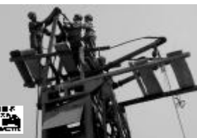
近日,长铝建二公司顺利完成了一台塔式起重机的钢丝绳更换、润滑油保养等任务并车成功。 杨磊 摄影报道
