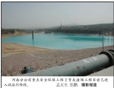
河南分公司重点安全环保工程2号灰渣场工程目前已进入试运行阶段。孟友光 张鹏 摄影报道
