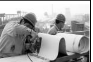
3 月 22 日,机械制造公司提前 4 小时圆满完成了氧化铝一厂八车间“溜槽透气管”更换工作。张艳文 马东辉 摄影报道
