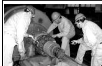
3 月 23 日,热电厂 3 号汽轮发电机可控制微机自动励磁系统改造工作经过 5 天的安装调试圆满完成。肖明 胡肃之 摄影报道
