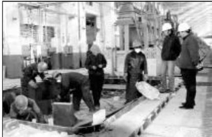
元旦佳节,长城铝业公司职工不亦乐乎,仍然奋战在各自的工作岗位上,用实际行动确保了河南分公司自备电厂、污水处理厂以及电解厂大修任务的稳步推进。图为长城铝业公司职工正在大修电解厂电槽。 杨福 摄影报道
