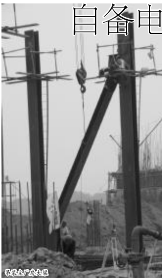
自备电厂厂房架梁
