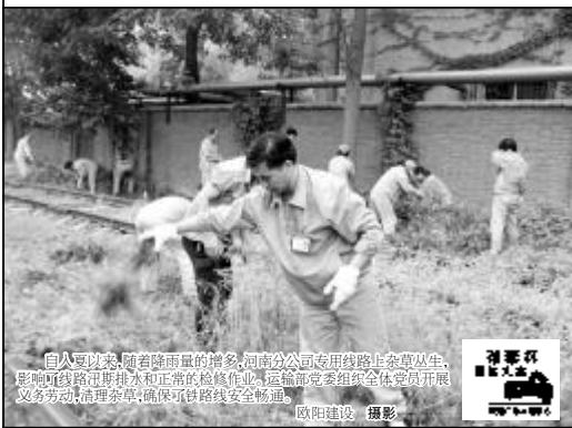
自夏以来,随着降雨量的增多,河南分公司专用线路上杂草丛生,影响铁路路基排水和正常的检修作业,运输部党委组织全体党员开展义务劳动,清理杂草,确保铁路线路安全畅通。 欧阳建设 摄影
