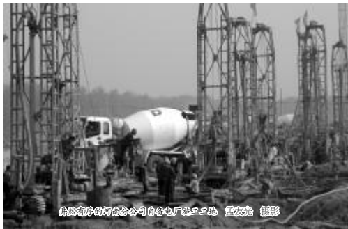
自备电厂施工现场
