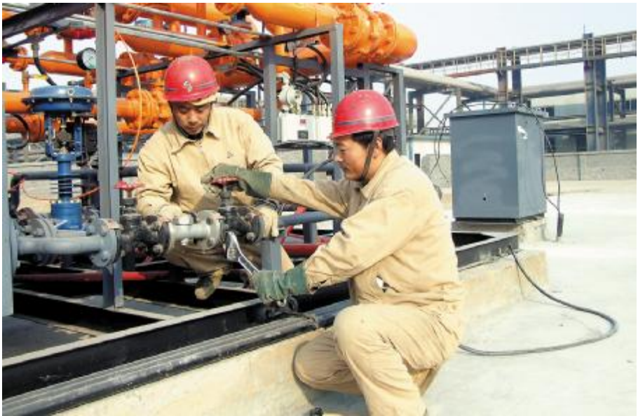
检修公司承建的天然气(煤层气)替代重油项目是河南分公司今年的重点项目,建成后每年可为公司创造经济效益 10 万元。为打造精品工程,该公司全体参战员工昼夜施工,经过四十多天的不懈努力,11 月 19 日,工程全面完工。图为施工现场安装设备的场面。邓广顺 摄影报道
