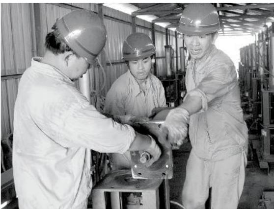
近日,自备电厂2号炉除尘器4号旁通阀自动关闭,自备电厂检修车间迅速组织员工拆除气缸,排查故障。冯慧武 王备战 摄影报道
