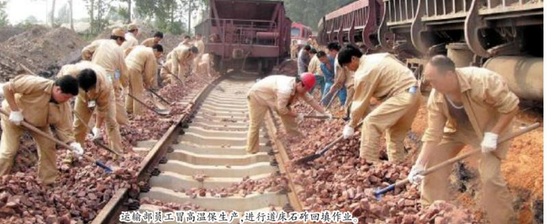
运输部员工冒高温保生产，进行道床石砟回填作业。
