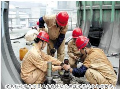
水电厂检修车间员工在检修动力循环水泵站冷却塔风机。
