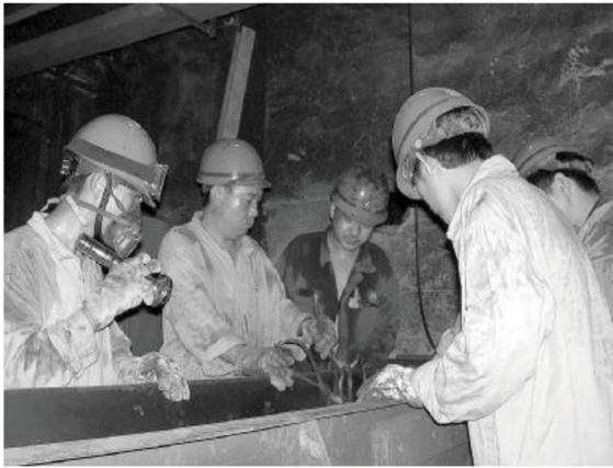
近日,热力厂9号锅炉炉内给煤机链条在运行中突然断裂,造成给煤中断。检修车间在做好防暑降温和安全检修工作的前提下,组织人员经过连续5个小时的艰苦作业完成了此次检修任务,并一次试车成功。苏志泉 摄影报道
