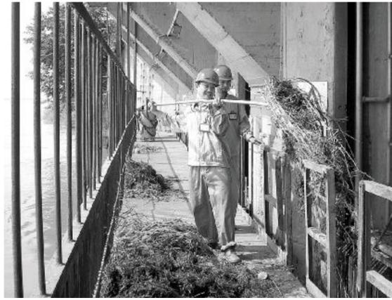
随着黄河小浪底调水调沙工作的继续进行,黄河上游顺流漂下了大量的杂草、树枝等杂物。这些杂物如不及时清理,一旦抽进取水泵内,就会造成设备的损坏。为了保证中铝郑州企业及居民用水的稳定供应,近日,水电厂黄河水源车间员工不顾骄阳似火、蚊虫叮咬,自觉增加了打捞杂草杂物的次数。图为泵站员工在黄河取水口捞取杂草杂物。高建华 摄影报道
