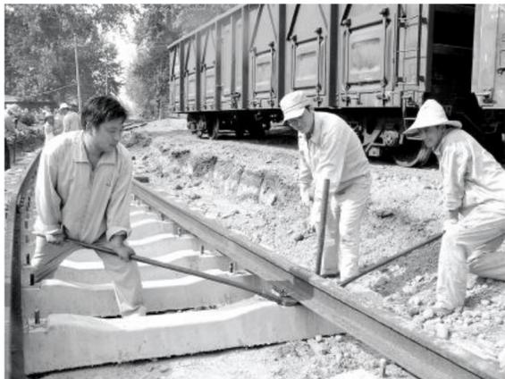
自8月份河南分公司铁路专用线物资库西延伸线路铺设以来,担负着线路铺设任务的运输部工务段广大党员在急难险重任务面前,时刻冲在前,干在先,处处以自己的表率作用感染并带动员工,全力以赴投入到200米长延伸线路的铺设中,为线路的顺利完成奠定了坚实基础。图为8月16日,工务段工业站工区区长、党员袁建辉(左一)带领班组成员校正钢轨。
