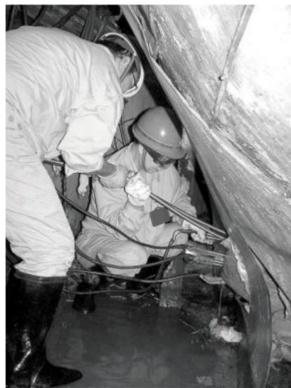
持续高温,对电气设备稳定运行构成了威胁。7月30日,氧化铝厂电气车间点检班利用高压水枪和自制的锯条清道器将二、三、四管道化变配室的空调清理一新,确保了空调正常制冷,确保了电气设备的稳定运行。图为班长张联华(左一)带领班组成员清理空调室外机。
