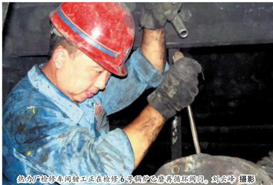
热电厂检修车间钳工正在检修6号锅炉2号再循环网。刘云峰 摄影
