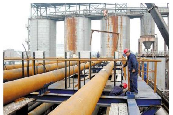
8月12日,由建设公司承建的河南分公司氧化铝管道溶盐技改项目取得了阶段性胜利,溶盐管道带水试压一次成功并全面进入电气安装阶段。图为施工人员正在现场作业。 杨磊 摄影报道
