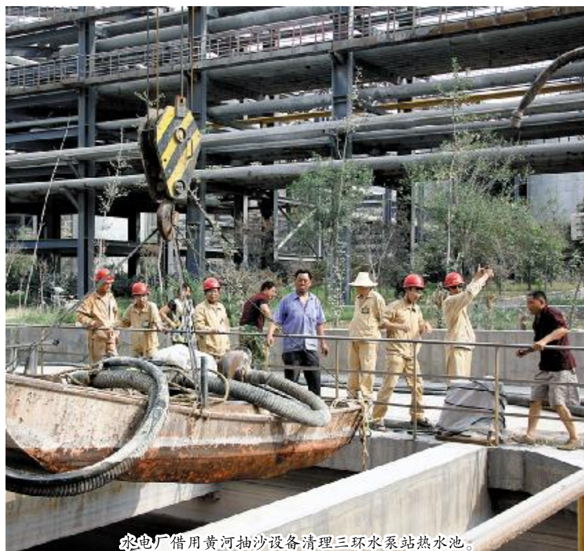
水电厂借用黄河抽沙设备清理三环水泵站热水池。
