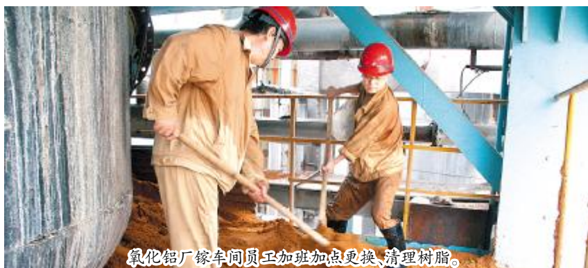
氧化铝厂炼车间员工加班加点更换、清理树脂。
