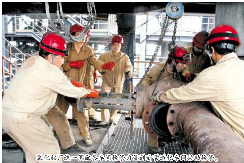
氧化铝厂统一调配各车间检修力量到新管道化车间协助检修。
