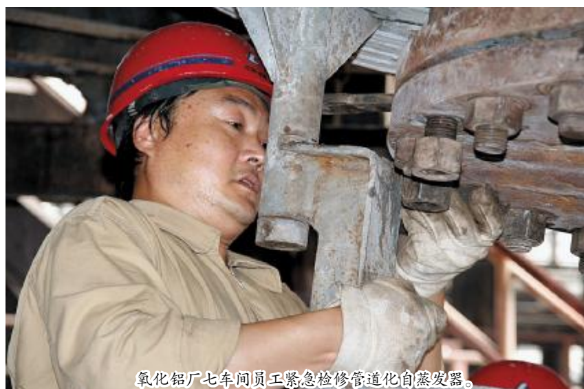
氧化铝厂七车间员工紧急检修管道化自蒸发器。
