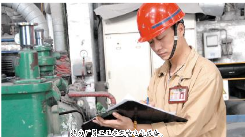
热电厂员工在巡检电气设备。
