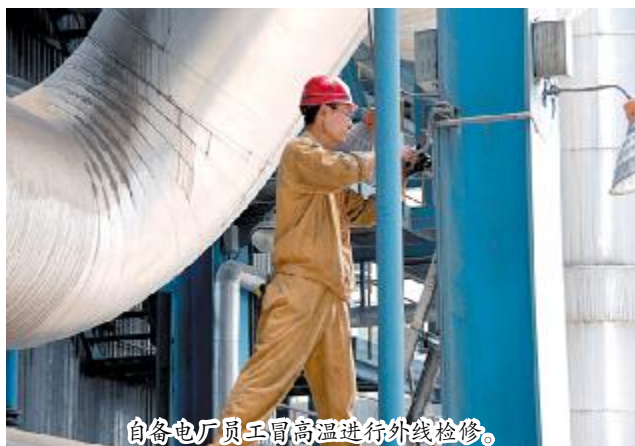
自备电厂员工冒高温进行外线检修。
