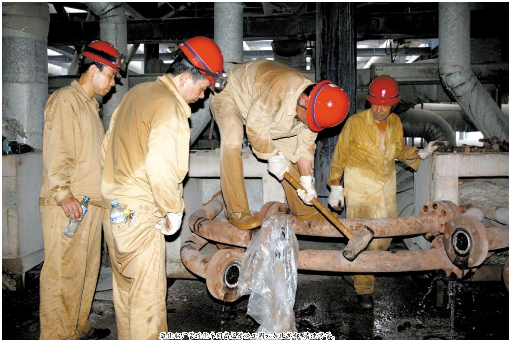
氧化铝厂管道化车间高压清洗工周六加班拆卸、清洗弯管。
