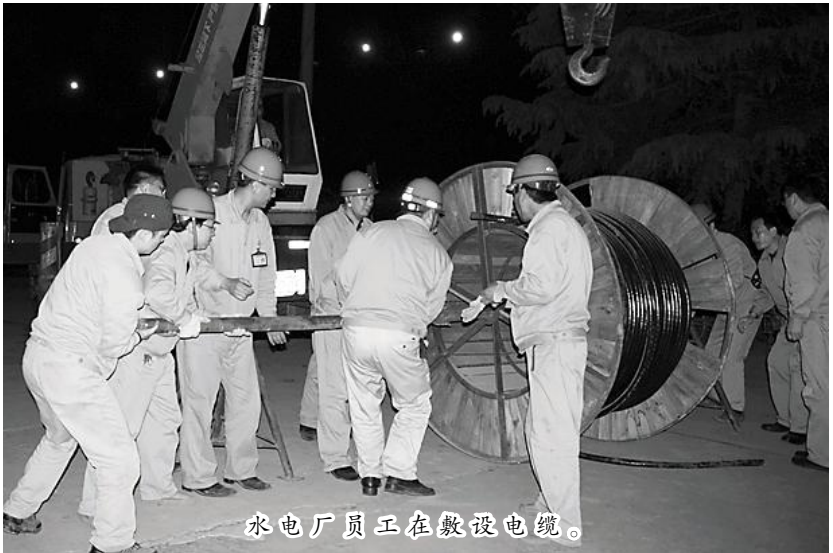
水电厂员工在敷设电缆。
