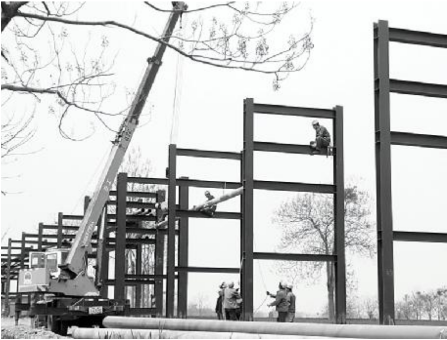
由工程设计总公司工程公司承建的河南分公司第五赤泥库外排管线架设项目,在工程公司领导和参战员工的辛勤努力下,目前已架设管线2.5公里,架设跨越丘陵、农田、河流、公路、居民区管道架370座,架设管道33公里。图为员工在架设管道。
