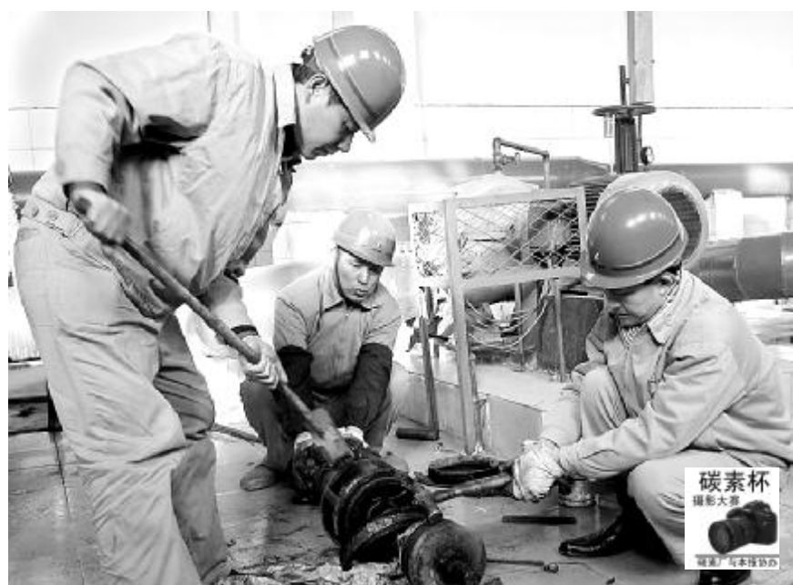
为确保春节期间生活水的安全稳定供给，水电厂提前着手，对供水设备进行检修。图为检修车间员工正在认真检修生活水过滤器。 贺亚妮 摄影报道
