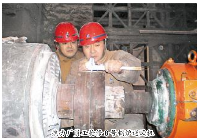
热电厂员工检修8号锅炉送风机
