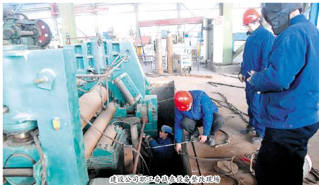
建设公司职工奋战在设备整改现场
