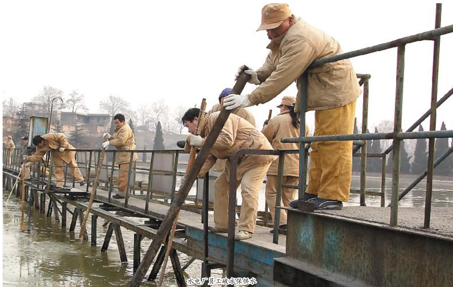
水电厂员工破冰保供水
