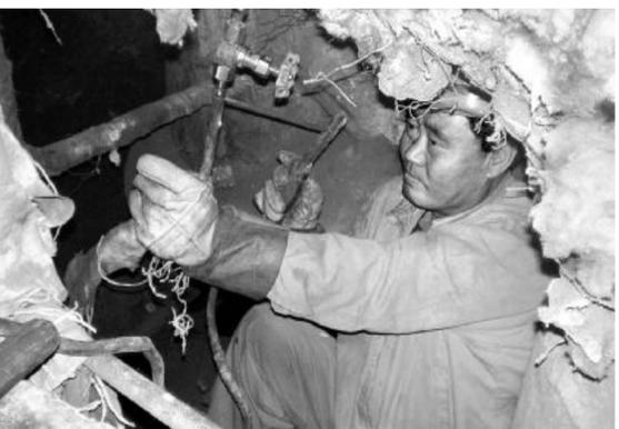
▲12月7日下午5点40分,热电厂检修车间员工发现5号汽轮机测压管堵塞,如不及时处理,将给汽轮机的正常运行埋下隐患。检修车间急生产之所急,立即组织人员对测压管进行了检修,保证了生产的正常运行。
