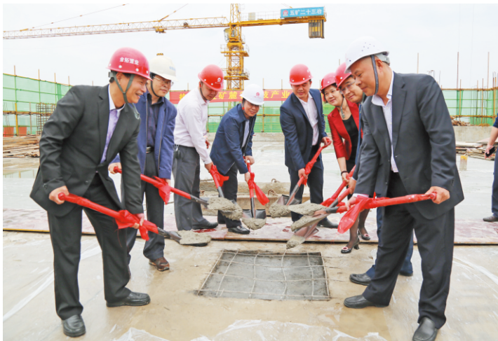
图为出席仪式的领导在为项目封顶浇筑混凝土 李可/摄
